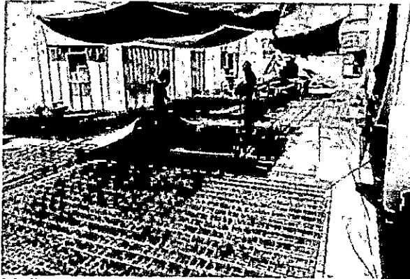
Mallas de acero para la rampa ubicada en el pasillo de circulación entre los bloques de comercialización y desinfección.
