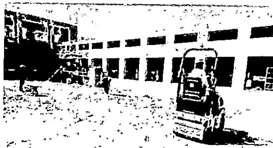
Compactación de material de subbase en el patio de maniobras.
